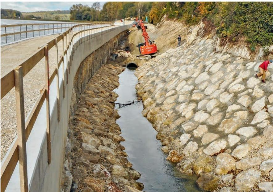
Abb. 9: Öffnung der Finkensteinverrohrung als Bestandteil der Fischaufstiegsanlage.
