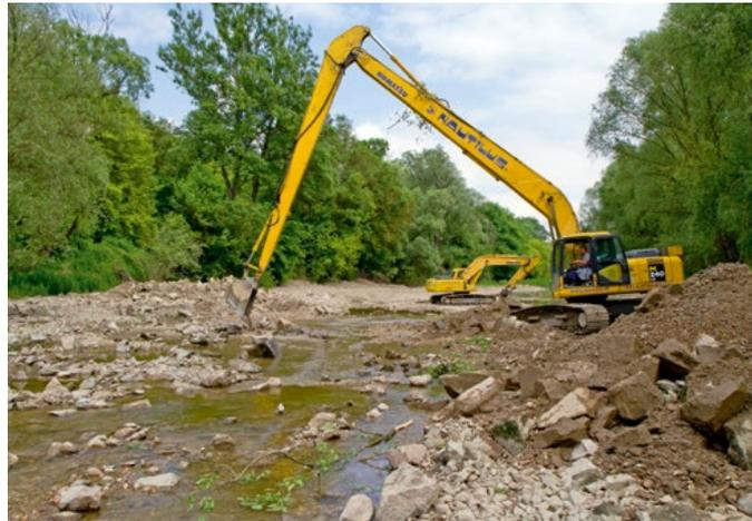
Abb. 2: Absenkung der Zu- und Abläufe zur Wiederanbindung der Seitenarme an die Donau. (Foto: BROZ)
