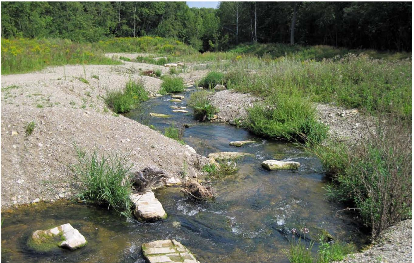
Es leitet Donauwasser in einen neu errichteten Gewässerabschnitt, den Ottheinrichbach, überquert den als Binnenentwässerungsgraben für die Staustufe genutzten Längenmühlbach mittels Trogbücke, fließt durch den angrenzenden Auwald und mündet nach ca. 4 km in einen bestehenden Bachlauf, den Zeller Kanal. Dieser mündet in die Donau.
