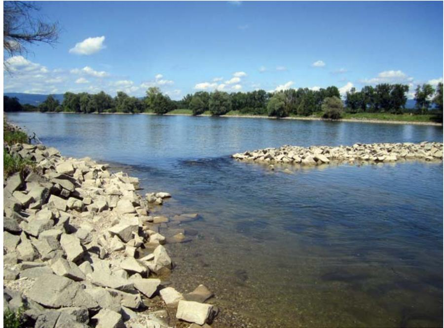
Die Absenkung einer Buhne am landseitigen Anschluss (wie hier wohl unbeabsichtigt bei Aicha entstanden) kann die Strömungsverhältnisse im Buhnenfeld deutlich verbessern und die Umlagerung von Material erhöhen. Foto: Georg Kestel.
