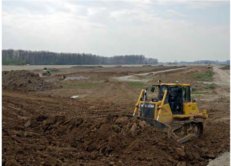
Foto 3: Baustelle der Ausgleichsfläche „Natternberg - Teil Ost“. Flächiger Bodenabtrag zur Herstellung des Standorts für tief gelegene Weidenauen.
