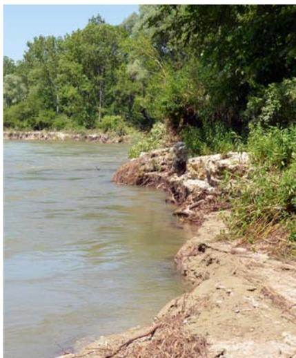
Abb. 4: Eigendynamische Gewässerentwicklung nach Uferrückbau an der Mittleren Isar (Foto: Wolfgang Kraier).
