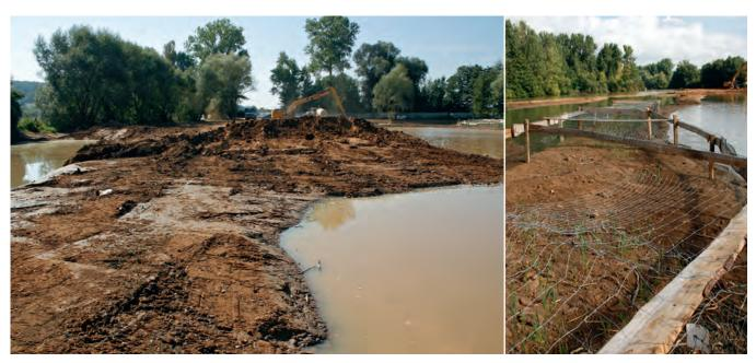
Abb. 5: Einbau des bindigen Erdmaterials für die Gestaltung von Flachwasserzonen im Baggersee "Ochsenanger"
