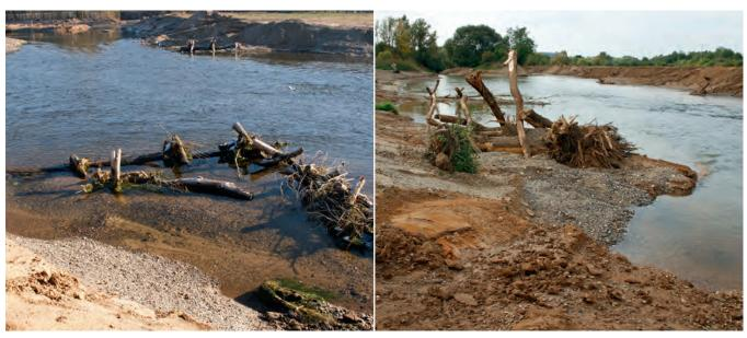
Abb. 7: Eingebaute Strömungslenker aus Totholzmaterial dienen gleichzeitig als Strukturelemente
