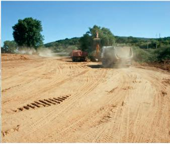
Abb. 6: Schichtenweiser Abtransport der Erdmassen
