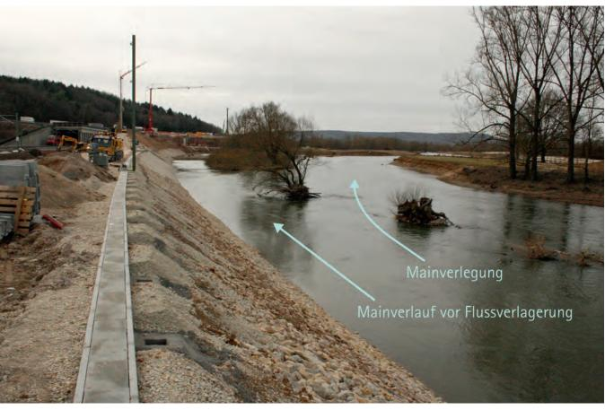
Abb. 2: Blick auf die gesicherte Bahndammböschung, den teilverfüllten alten Mainverlauf und den neuen Flusslauf rechts
