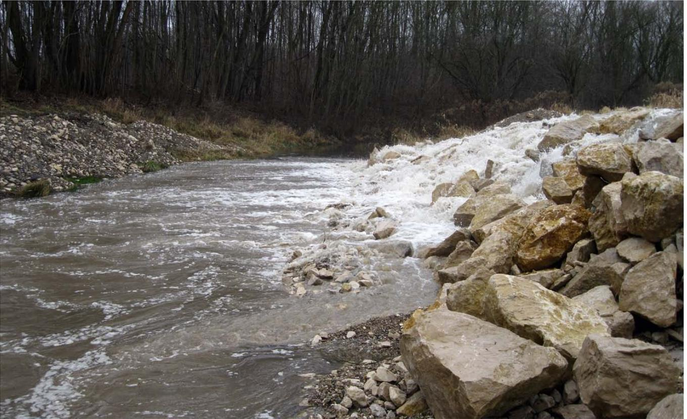
Abb. 2: Donauwasser strömt dem Langenmühlbach zu, nachdem es aus der Donau ausgeleitet wurde. Der Längenmühlbach, an seiner Mündung durch ein Drosselbauwerk verschlossen, sorgt für den Weitertransport bis in den Auwald (Foto: Fischer 2012)
