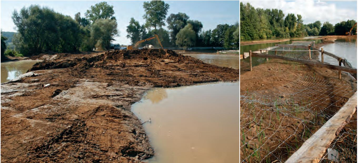
Abb. 5: Einbau des bindigen Erdmaterials für die Gestaltung von Flachwasserzonen im Baggersee „Ochsenanger“
