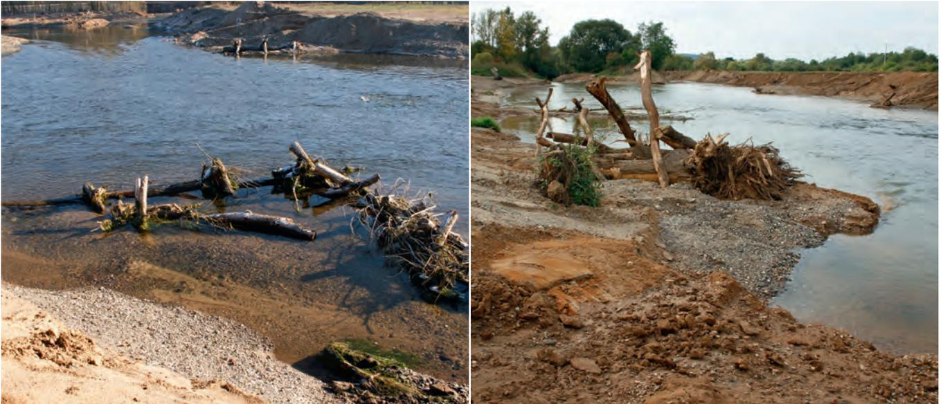
Abb. 7: Eingebaute Strömunglenker aus Totholzmaterial dienen gleichzeitig als Strukturelemente
