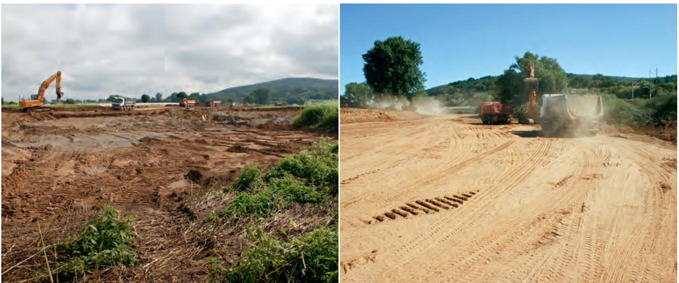
Abb. 6: Schichtenweiser Abtransport der Erdmassen
