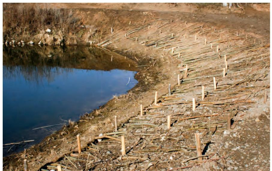
Abb. 4: Eingebaute Weidenspreitlagen im Bereich der Furt 2
