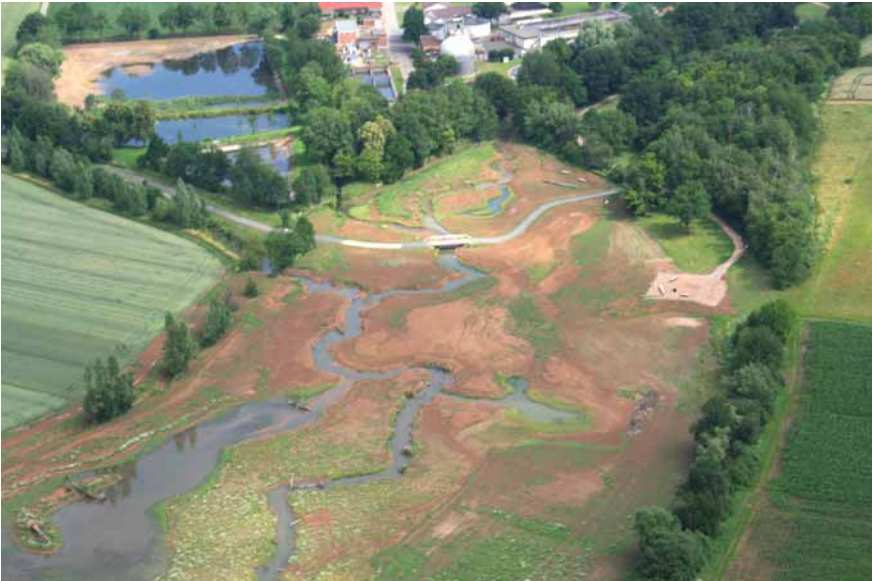
Abb. 4: Luftbild von der neuen Gewässerlandschaft im Bauabschnitt IV (Foto: N. Schneider, 18.07.2007)
