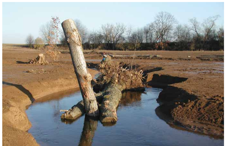
Abb. 3: Einbau von Totholz in die „neue Wern“ (Foto: N. Schneider, 23.01.2006)
