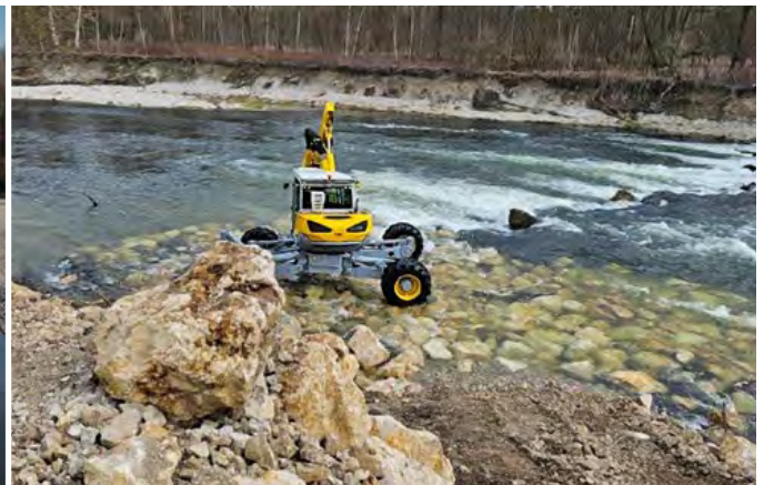
Abb. 7: Der Umbau von mehreren meterhohen Abstürzen hat an der Mittleren Isar die Durchgängigkeit nicht nur für Fische, sondern für alle Gewässerorganismen hergestellt. (Foto: WWA München)
