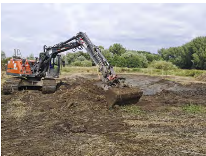
Abb. 6: Baggerarbeiten zur Herstellung eines Tidetümpels (Foto: WSA Elbe-Nordsee)
