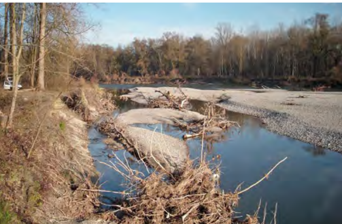
Abb. 6: Nach dem Entfernen der Längsverbauung entstehen an der Mittleren Isar durch Eigenentwicklung wieder wildflusstypische Lebensräume (Foto: WWA München)
